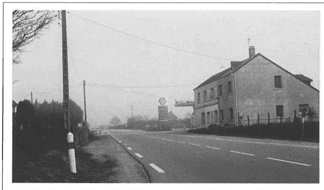
Garage-station service le long de la RD 650
